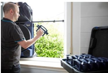
Abb. 17: Befestigen der Folie mit Klammern
