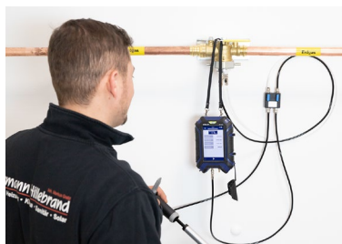
Abb. 21: Anschluss mit dem Wöhler Gasleitungsdichtheitsprüfset für die Belastungsprüfung
