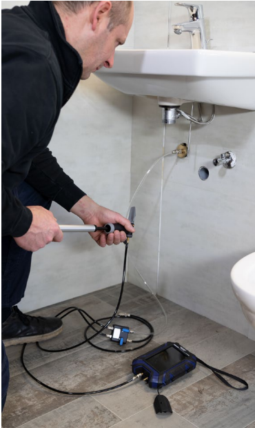
Abb. 52: Aufpumpen der Wasserleitung mit Luft, Dichtheitsprüfarmatur über Hochdruckstufenstopfen an Wasserleitung angeschlossen
