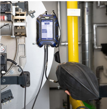
Abb. 5: Anschluss des Wöhler M 603 für die automatische Gebrauchsfähigkeitsmessung mit gefüllter Gasblase
