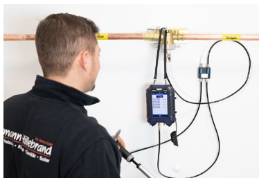
Abb. 37: Anschlüsse für die manuelle Gebrauchsfähigkeitsprüfung
