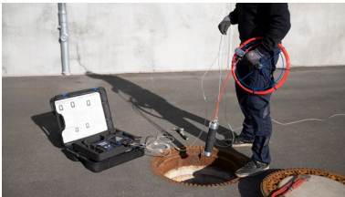
Abb. 70: Positionieren der Abdichtblase im Rohr
