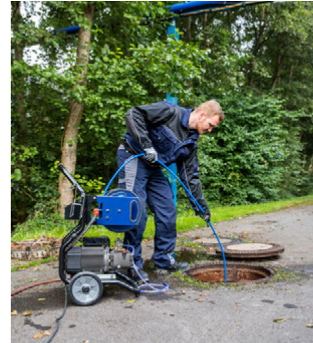
Effektive Reinigung durch extra Rohrreinigungsdüsen und langem Rohrreinigungsschlauch.
